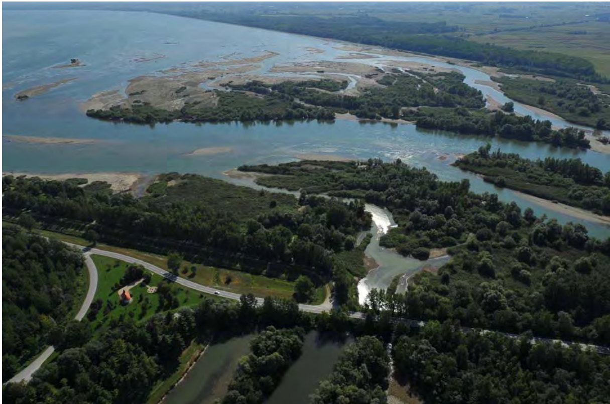
Slika 1: Pogled iz zraka na početku akumulacije u listopadu 2015. – u vrijeme ispuštanja vode iz akumulacije – vidi se zapadni završetak k,č, 8030/14 (izvor: Idejni projekt)
