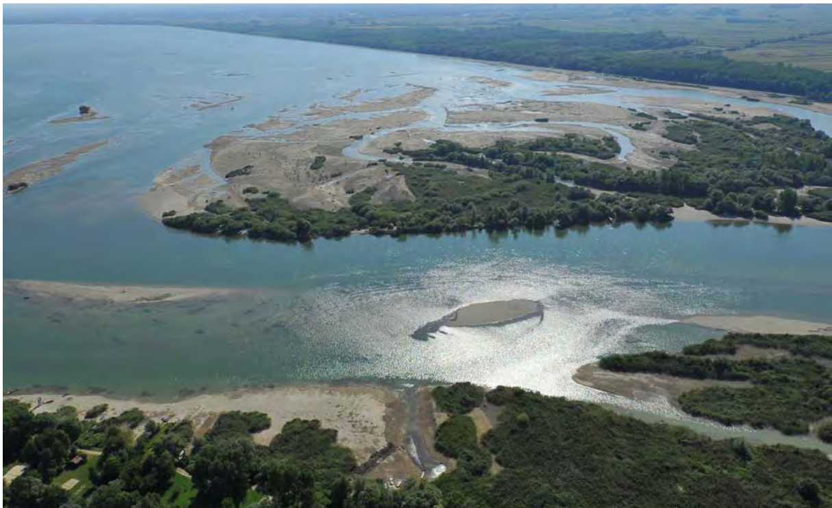
Slika 2: Pogled iz zraka u listopadu 2015. – u vrijeme ispuštanja vode iz akumulacije (izvor: Idejni projekt)
